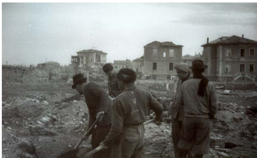
Fig. 2 – Rimini 1946, operai comunali coordinati dal geometra Enzo Zavatta scavano a mano con attrezzi di fortuna le buche profonde un metro da riempire con calcestruzzo su cui innalzare i piedritti di centimetri 30 per 30 necessari per la posa delle baracche di legno del CEIS (AMZ, CEI-0242_015).
