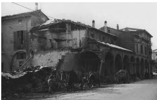
1. Danni all'edificio comunale di San Lazzaro, lato lungo la via Emilia.
